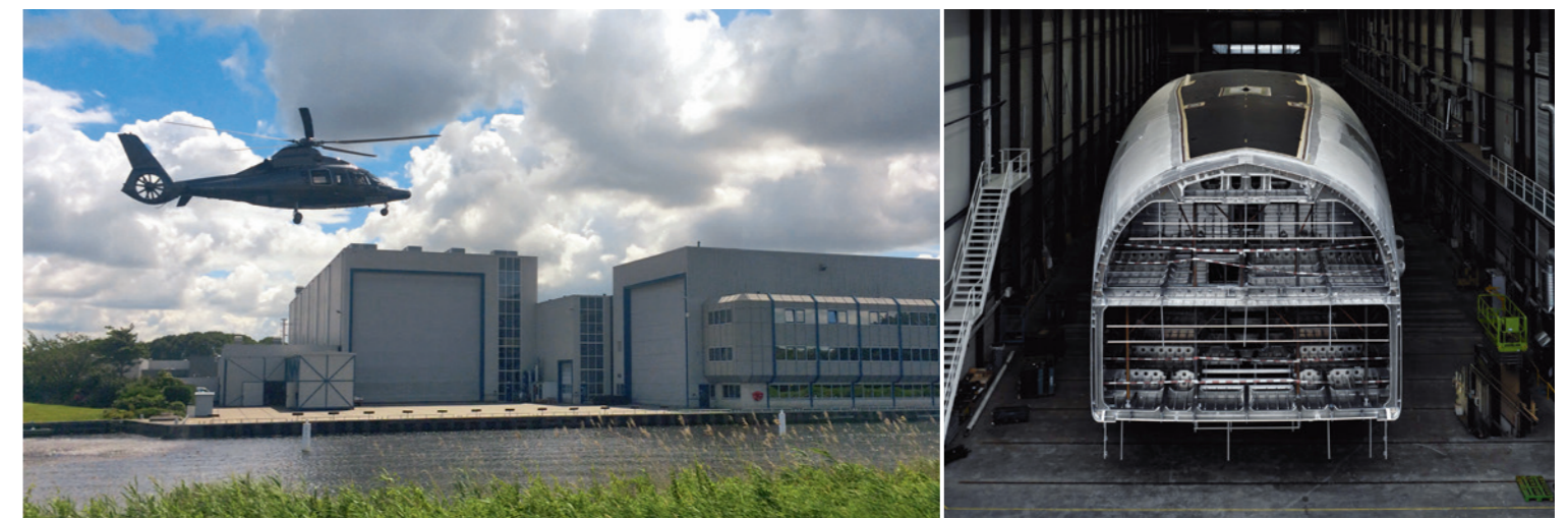
Royal Huisman in Vollenhove: Der Vorplatz der größten, für die 85-Meter-Slup abermals verlängerten Halle dient auch als Heliport. Den Rumpf von Baunummer 410 (r.) schweißten die Yachtbauer aus Alu. Seit Anfang der 2000er-Jahre setzen die Niederländer für Großyachten auf das Leichtmetall.
